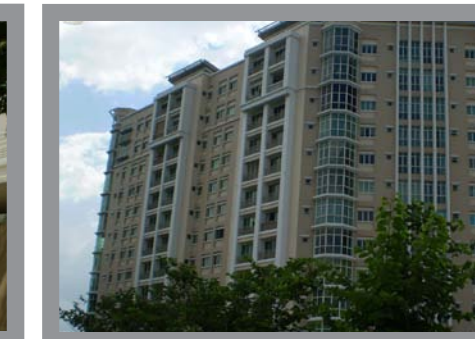
Sutramas Condominium - KL Malaysia
