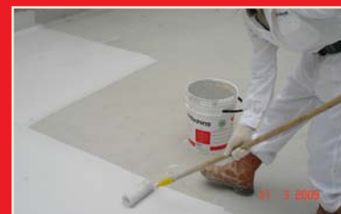
1. Application of Primer coat
